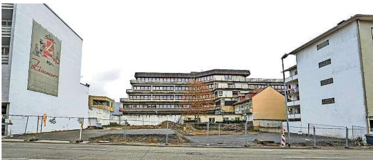
Noch blicken Passanten und Fahrer an der Berliner Straße durch diese unansehnliche Brache auf die Arbeitsagentur.
