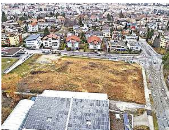
Die Bebauung an der Postwiesenstraße schreitet voran. Im gerodeten Feld an der Vogesenallee entstehen vier Mietshäuser.
